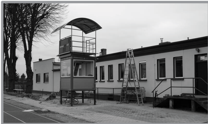
PRACE REMONTOWE OSIR
