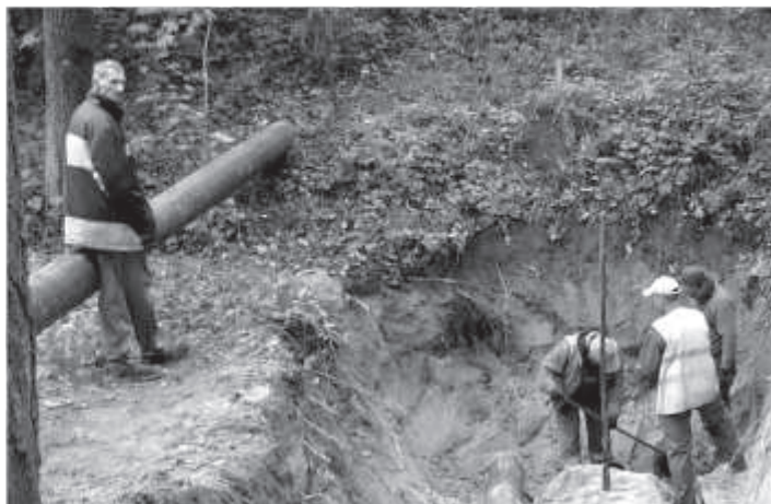
Prace przy budowie kanalizacji sanitarnej
