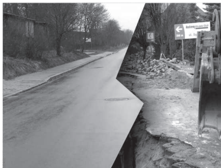
Przebudowa ulicy PCK
