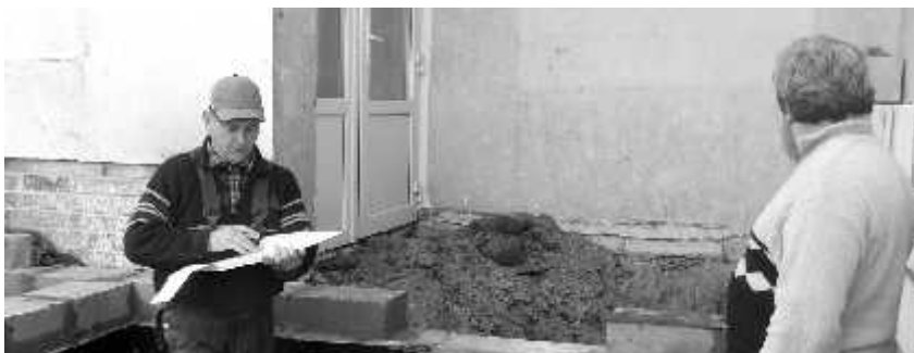
Budowa Centrum Kultury i Folkloru w Dąbrówce Wlkp.
