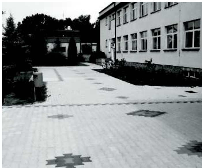
Plac przed szkołą po remoncie
