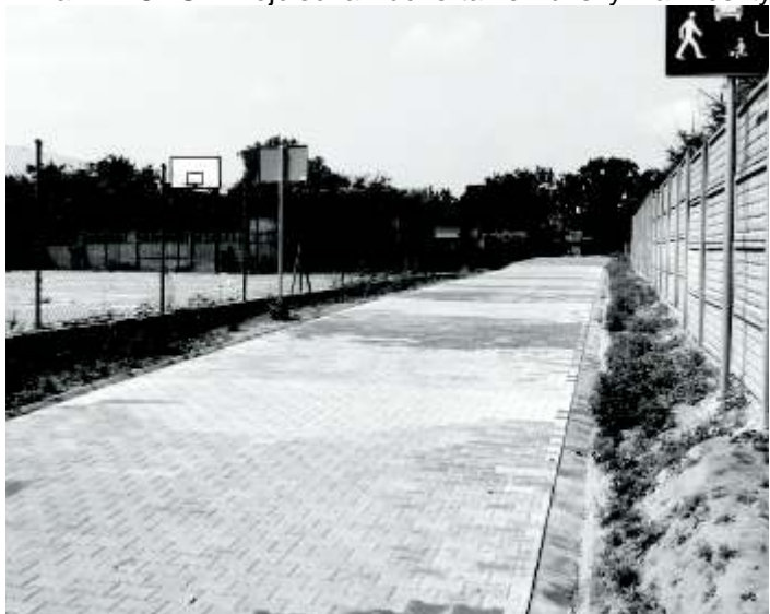
ul. Wrocławska po zakończeniu budowy
