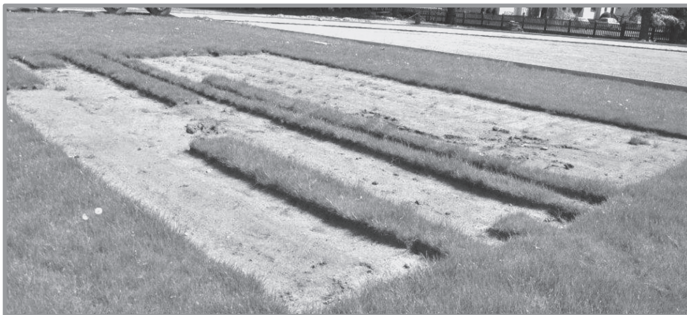
PRZEBUDOWA STADIONU MIEJSKIEGO W ZBASZYŃKU - TRWAJĄ PRACE ZWIĄZANE Z BUDOWĄ BIEŻNI I PŁYTY GŁÓWNEJ
