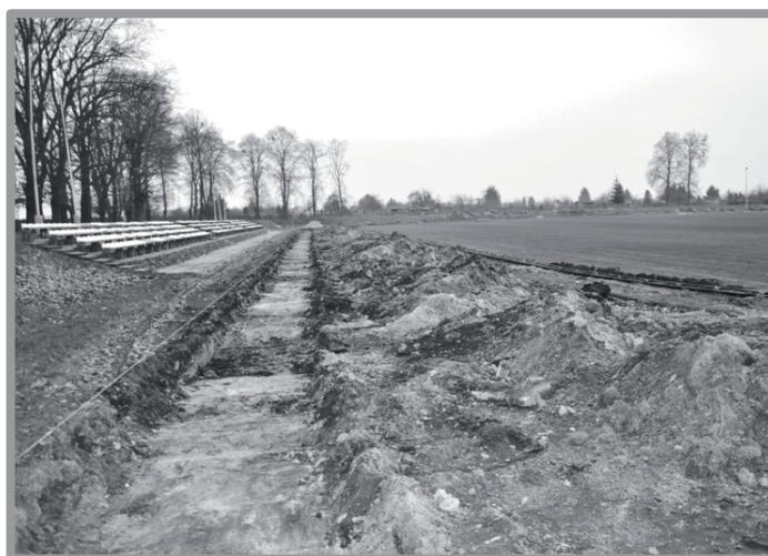
W PAŹDZIERNIKU ROZPOCZĘŁA SIĘ PRZEBUDOWA STADIONU W ZBĄSZYNKU
