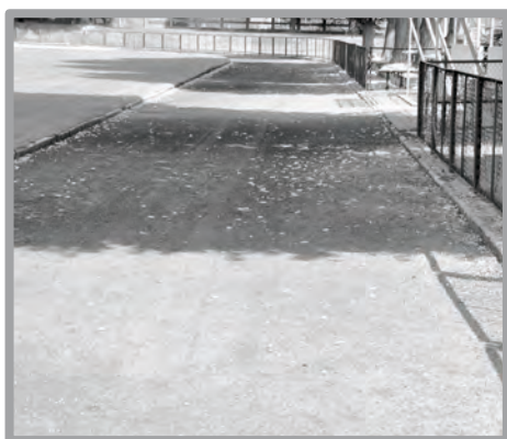
PRZEBUDOWA STADIONU MIEJSKIEGO W ZBĄSZYNKU 29 września rozpoczęła się przebudowa stadionu miejskiego w Zbąszynku
