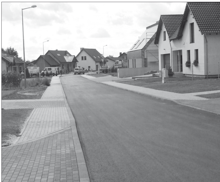
Nowa nawierzchnia ulicy Kościelnej
