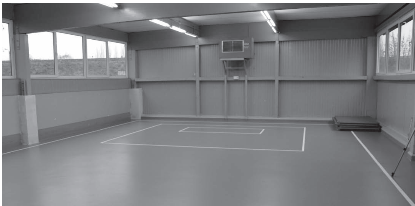
Nawierzchnia salki gimnastycznej po remoncie
