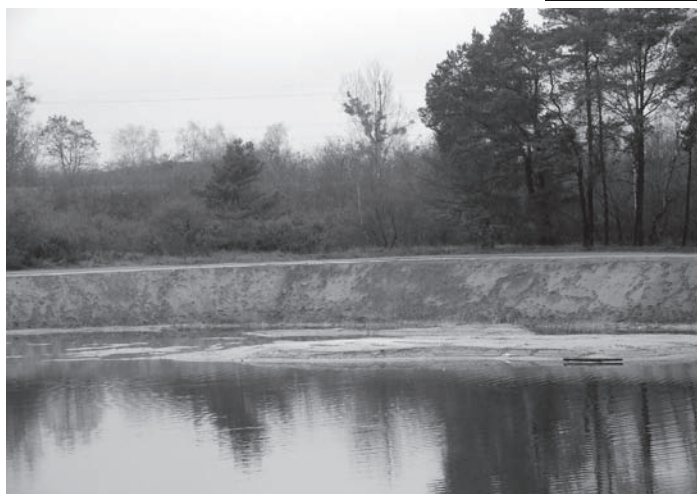
Zbiornik retencyjny w Chlastawie
