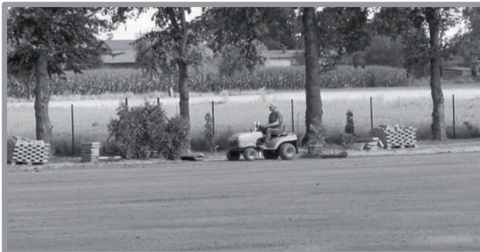
RENOWACJA PŁYTY WRAZ Z SYSTEMEM NAWADNIANIA - INWESTYCJA W DĄBRÓWCE WLKP.
