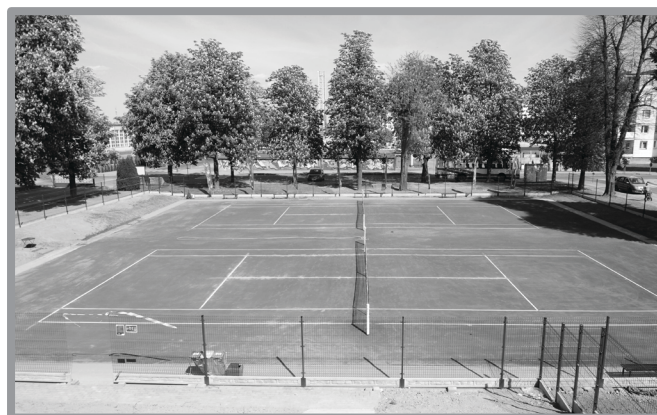
MODERNIZACJA KORTÓW TENISOWYCH
