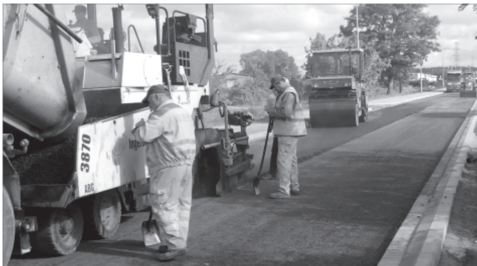
Układanie nawierzchni ulicy PCK
