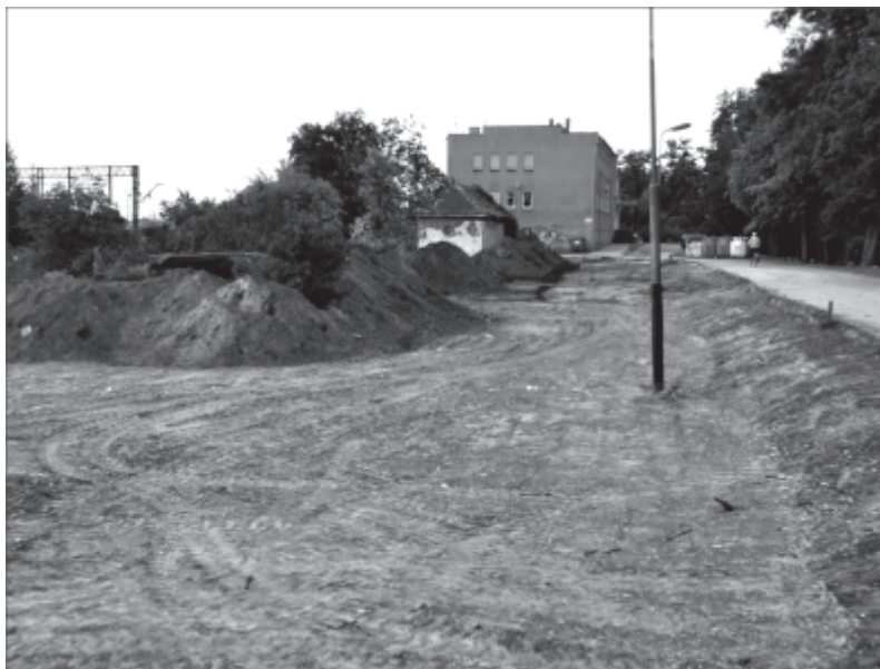
Prace przy budowie parkingu i teren rekreacyjno-wypoczynkowy
