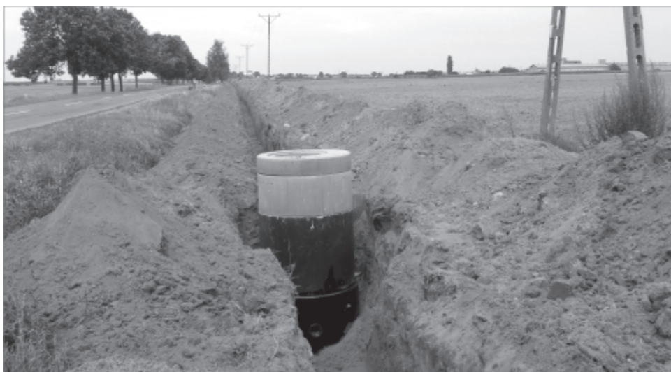
Budowa kanalizacji między Dąbrówką Wlkp., a Rogozińcem
